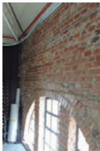
Imagens 5 e 6: Parede com arcos para a fachada principal e Instalações aparentes
